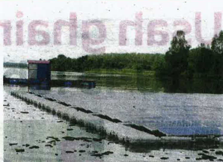
Pemasangan panel solar di Danau Tok Uban.
