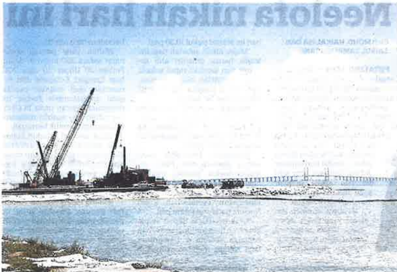
SEBAHAGIAN projek tambakan laut di perairan Queensbay, Bayan Baru yang dijalankan pada tahun 2017.
