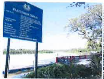
■施工，进度非常迅速 ■耗资20万令吉重建玉射河畔浮动码头
